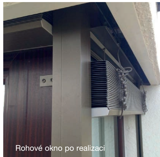
Řešení rohového okna pomocí ocelového sloupku a překladů KP Vario UNI R
