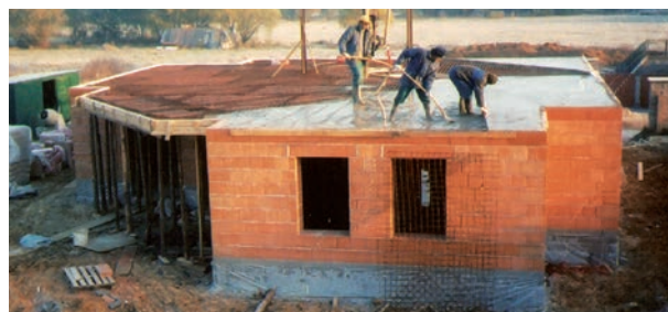
Položení stropu Porotherm
