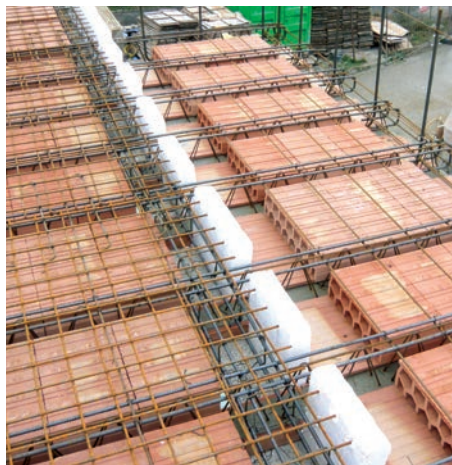
Konzola balkónu - vázaná výztuž před betonáží
