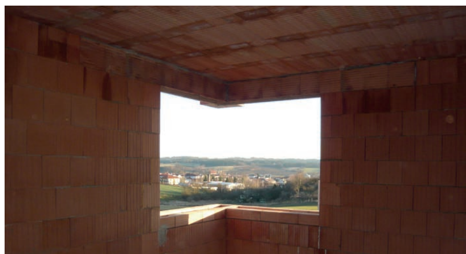
Vzorové provedení stropní konstrukce Porotherm
