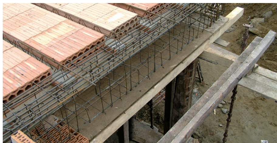
Rohové okno bez sloupku před betonáží
