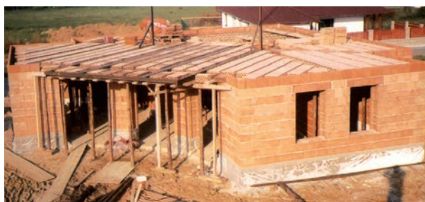
Položení stropu Porotherm
