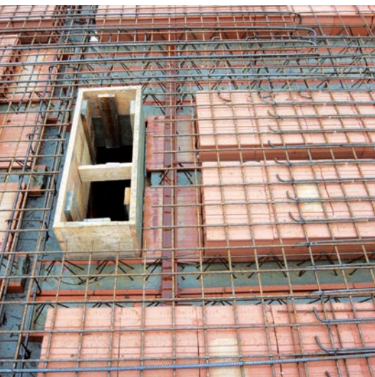
Komínová výměna pomocí úhelníku L 75/50/6
