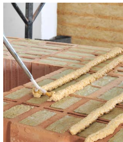
Aplikace lepidla na cihly plněné minerální vatou ve čtyřech pruzích
