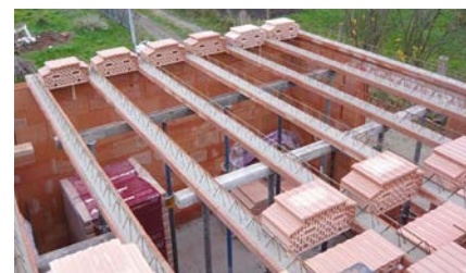
Obr. 3 Kladení vložek na předem podepřené trámy
