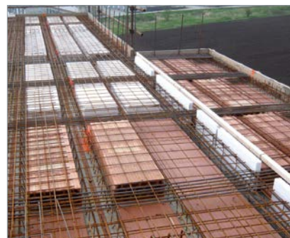
přerušení tepelného mostu mezi balkónem a stropem
