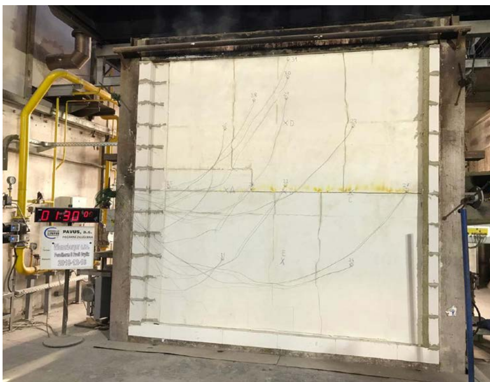
Zkouška oboustranně omítnuté příčky z cihel Porotherm 8 Profi Dryfix vyzděných na zdicí pěnu Porotherm Dryfix
