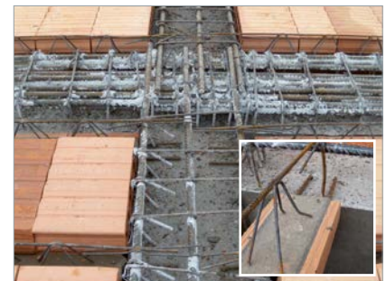
uložení trámečků do železobetonového průvzlaku
