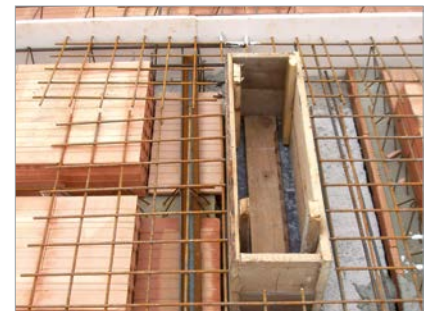
výměna u prostupu stropem pomocí vloženého úhelníku 75/50/6
